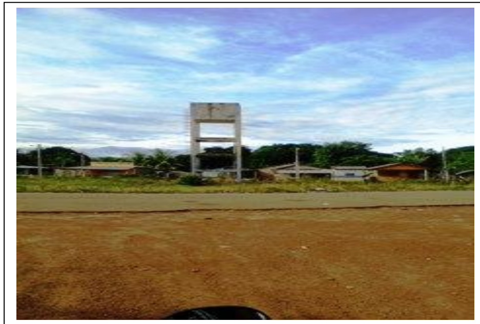
Figura 7.0 - Estação Elevatória da CAER na Vila de Vista Alegre Fonte: Nilcéia Canavarro, 2013.
