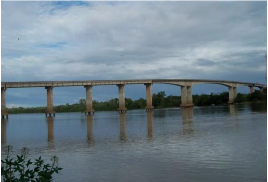
Figura 10 – Ponte Jose Vieira de Sales Guerra, sobre o Rio Branco, na Vila de Vista Alegre.
