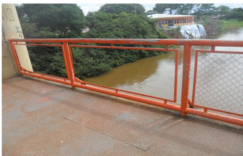
Figura 13: um grande perigo na plataforma, as grades foram arrancadas.
